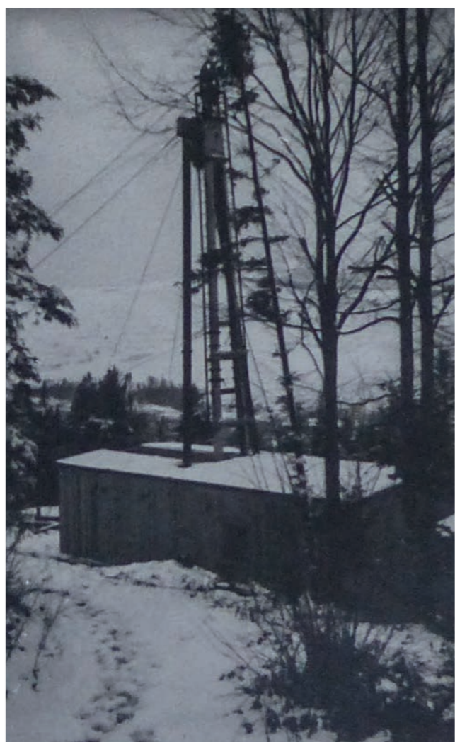
Żuraw wiertniczy SM 4 – kopalnia Wańkowa, 1937 r. Fot. zbiory A. Mikuckiego
