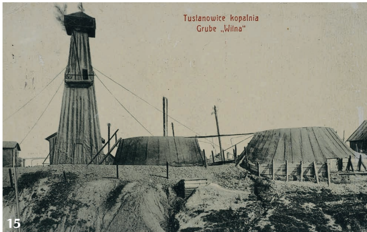
Копальня «Вільна» в районі Тустанович та дерев'яні нафтові збірники (15 – Фото 1910 р.) Kopalnia „Wilna” w dzielnicy Tustanowice i zbiorniki ropy (15 – Foto 1910 r.)
