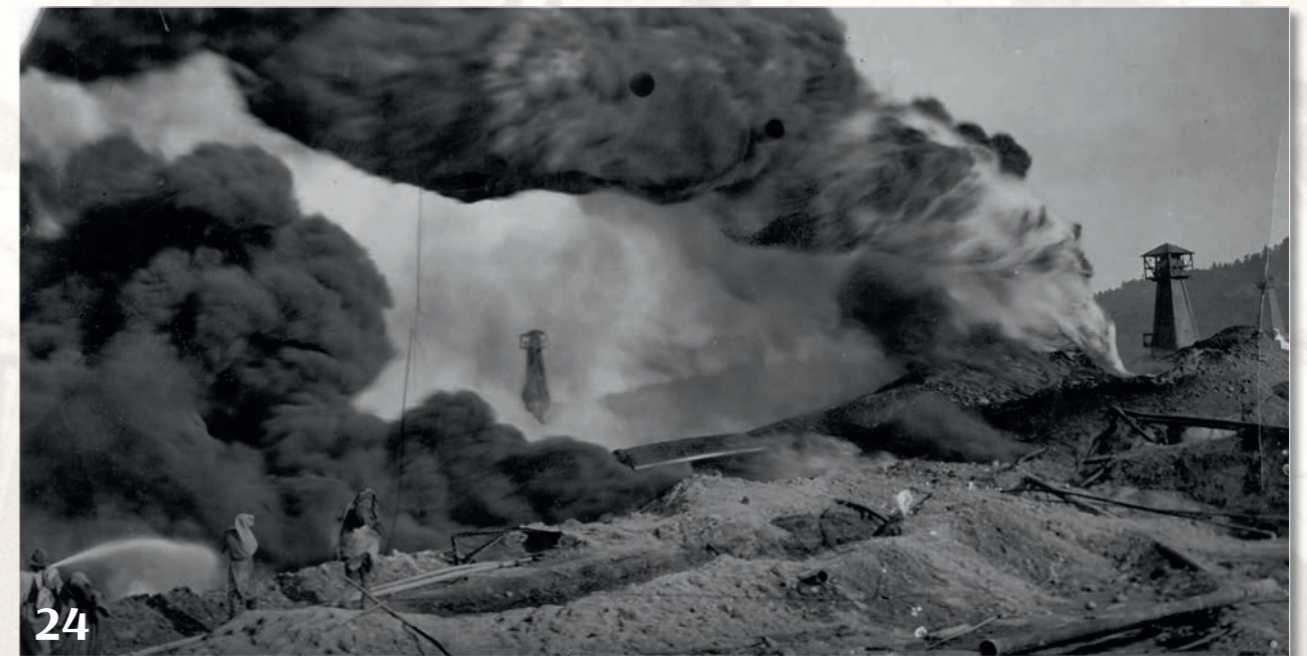
Безконтрольний видобуток нафти, що супроводжувався її масовими виливами (викид нафти на шахті в Бориславі – т.зв. «вибух») – (22), часто призводив до руйнівних пожеж (23; 24) (22 – Фото поч. XX ст.; 23 та 24 – Фото 1930-х рр.)
