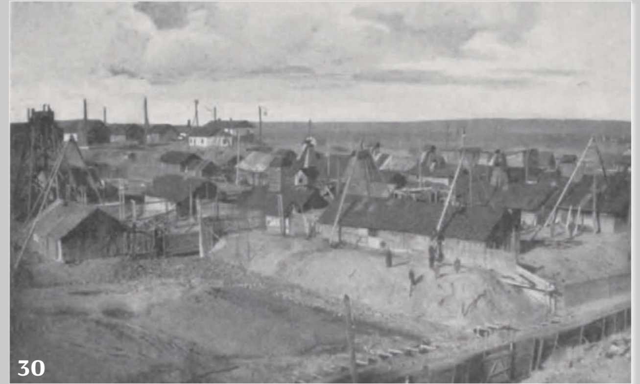
Розробки озокериту малими шахтами (криницями-копанками) фірми Compagnie Commerciale Francaise в районі Потік (30 – фото 1896 р.). У цьому районі Борислава великі поклади озокериту були відкриті Робертом Домсом в 1854 р., де він за два роки заклав перші шахти по його видобутку
